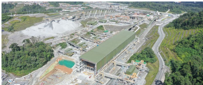
Planta de proceso antes de la suspensión de operaciones
