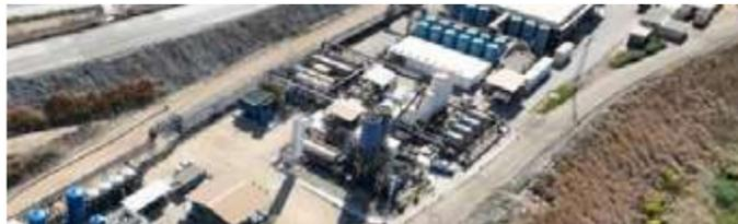
Las Cruces completó la expansión de su planta de tratamiento de agua permanente, incrementando su capacidad de tratamiento en un 50%. La planta utiliza tecnología que preserva y mejora la calidad del agua subterránea antes de su reinyección al acuífero. Las Cruces cesó el minado a cielo abierto en 2022.
